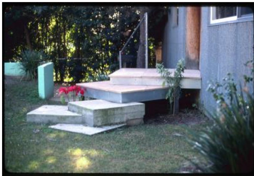
Santa Monica. Dettaglio della scala della Gehry House
