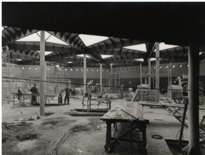
Interno del mezzanino della stazione Amendola Fiera a Milano
