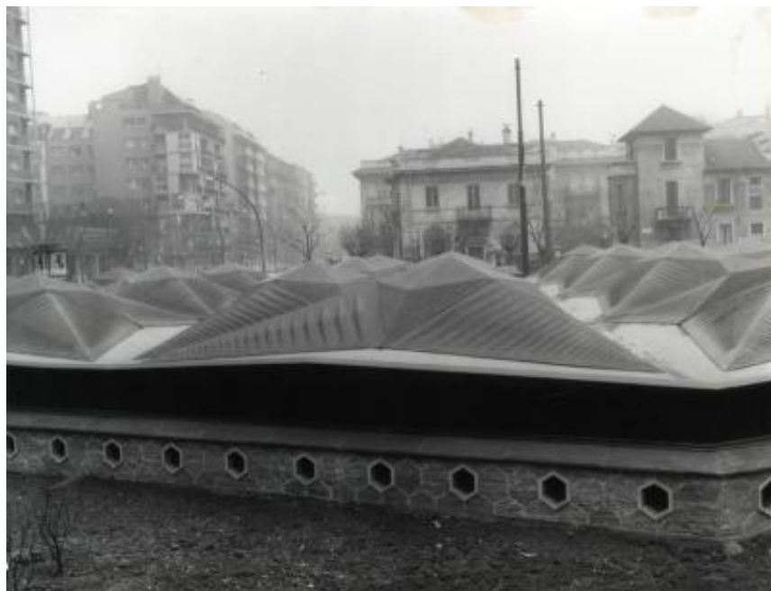
Dettaglio dell'esterno della copertura del mezzanino della stazione Amendola Fiera a Milano
