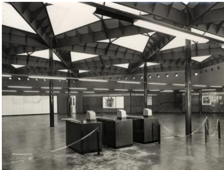
Obliteratrici nel mezzanino della stazione Amendola Fiera a Milano
