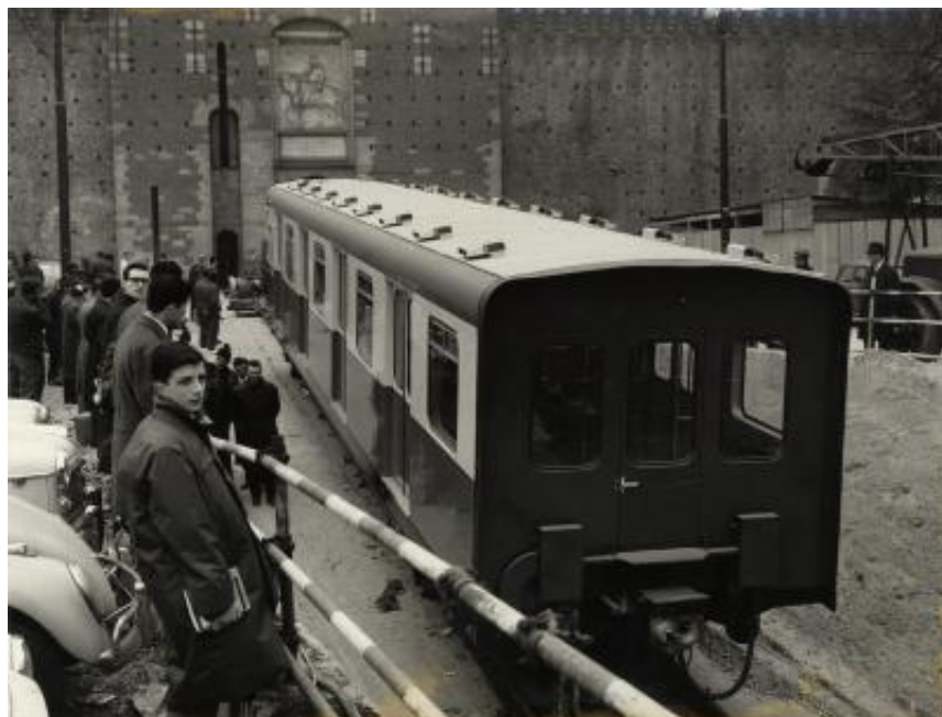
Vagoni della metropolitana calati nella galleria davanti al Castello Sforzesco a Milano
