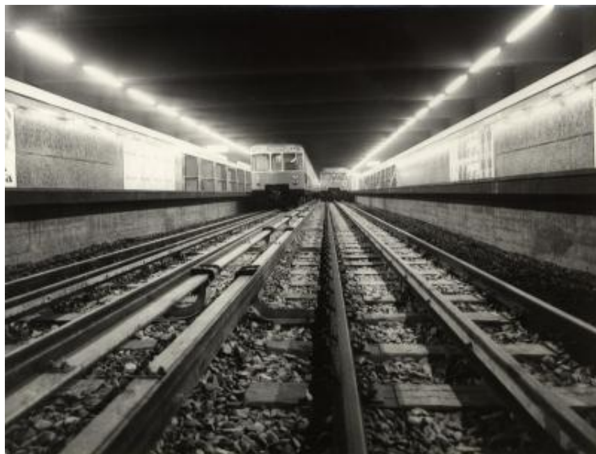
Interno della stazione Amendola Fiera a Milano, visto dai binari
