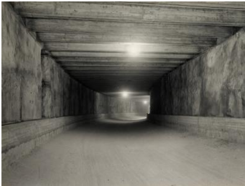
Tronco di galleria della metropolitana milanese ultimata
