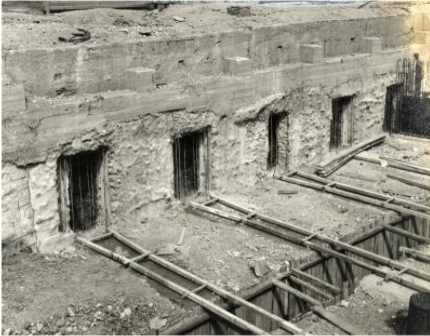
Particolare delle 'finestrature' per l'inserimento delle travi nel cantiere della metropolitana
