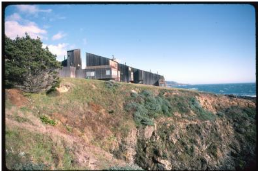
Sea Ranch. Veduta con il Condominium 1
