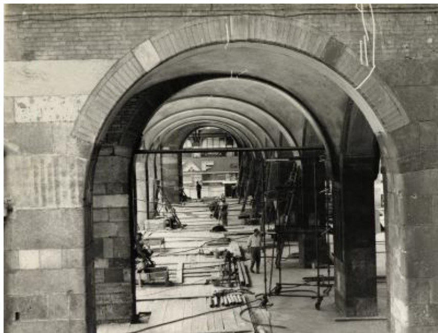
Cantiere dell'impresa Fondedile sotto la Loggia dei Mercanti
