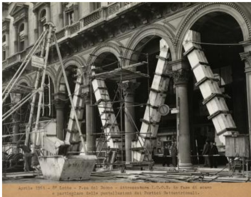
Attrezzatura I.C.O.S. in fase di scavo e particolare delle puntellazioni dei portici settentrionali in piazza Duomo
