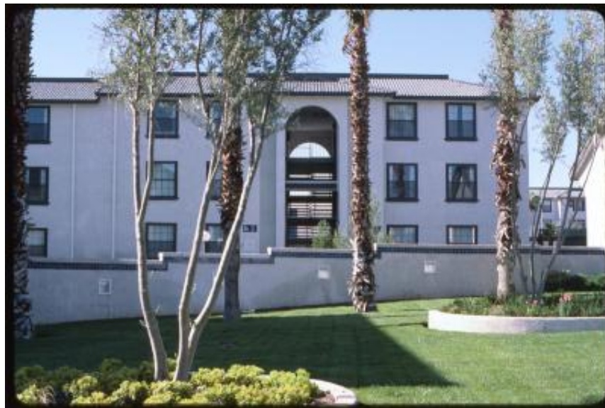
Las Vegas. Rancho Sahara in Sahara Avenue visto dal giardino
