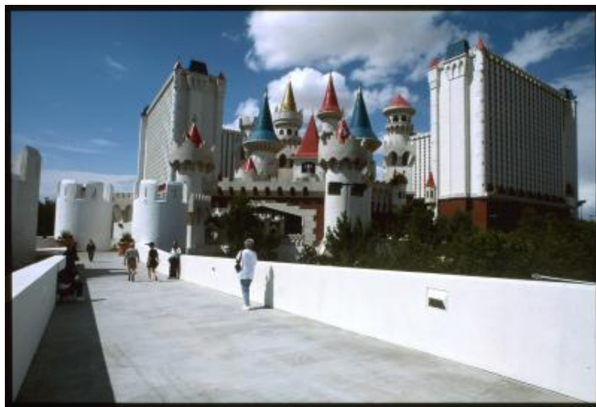
Las Vegas. Passerella che conduce all'Excalibur Hotel e Casinò
