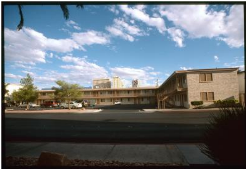
Las Vegas. Edificio di fronte allo Stratosphere Hotel
