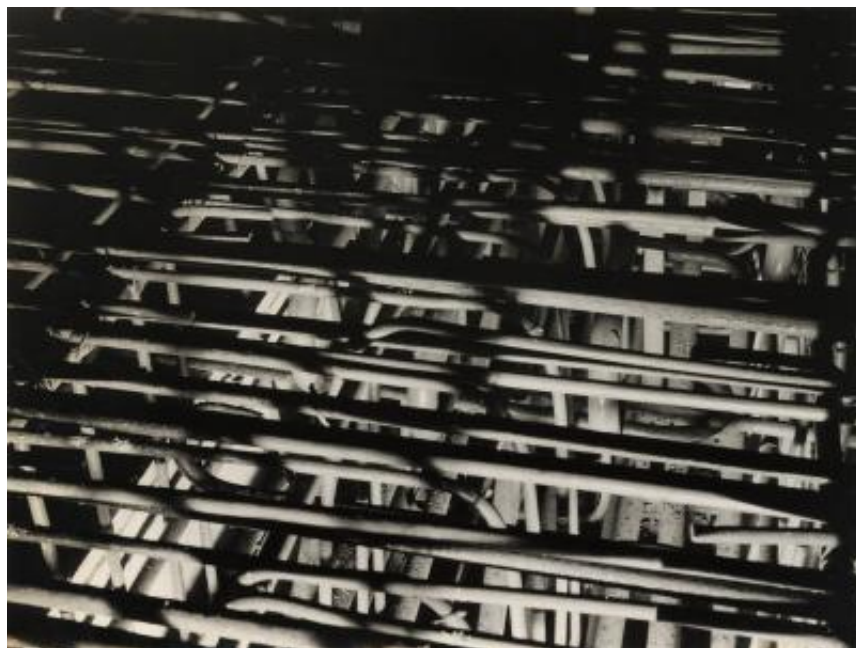
Armatura di un nodo della soletta intermedia della stazione di piazza Duomo a Milano
