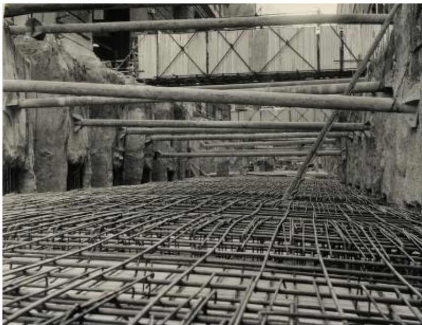
Armatura per il getto della soletta di copertura della galleria in corso Vittorio Emanuele II
