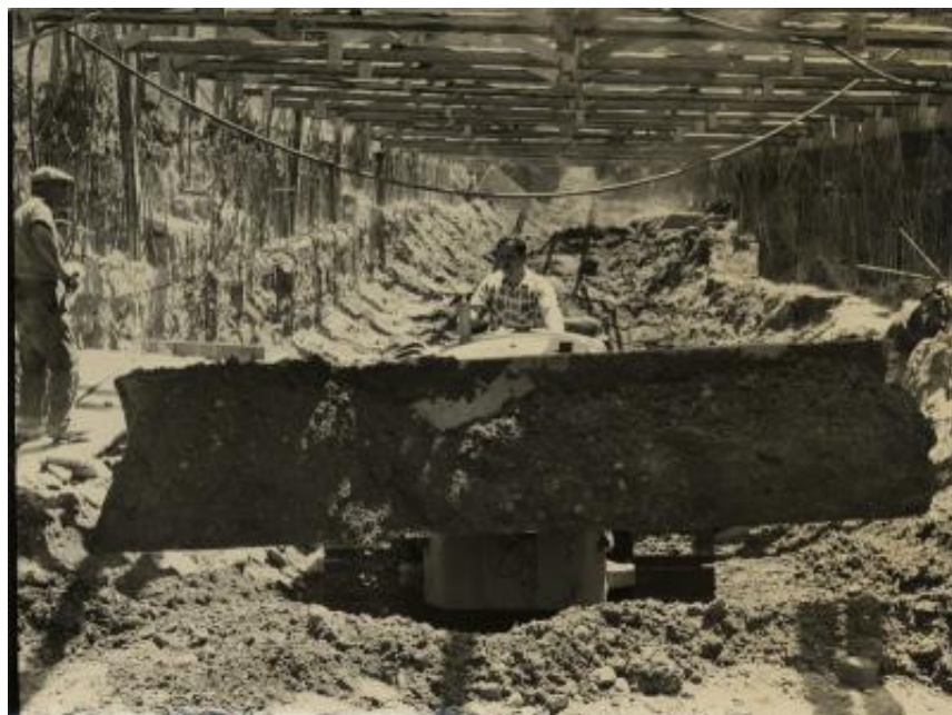
Dettaglio di uno scavo di sbancamento fra le paratie nel cantiere della metropolitana milanese
