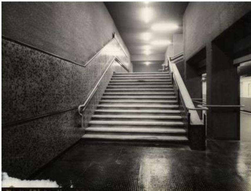
Scala di accesso ai binari di una stazione della metropolitana milanese
