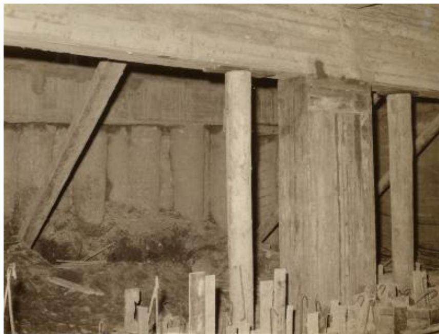
Pilastro di fondazione eseguito in sottomurazione nel cantiere della metropolitana milanese
