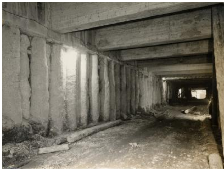
Particolare della paratia eseguita con pali nella stazione di piazza Lima a Milano
