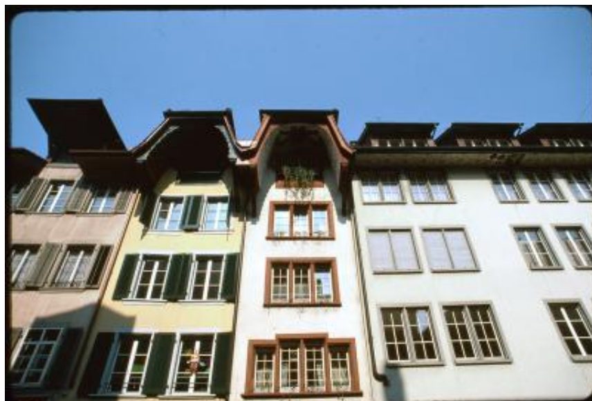
Aarau. Facciate di alcune abitazioni tipiche, collocate sul lato est della Rathausgasse
