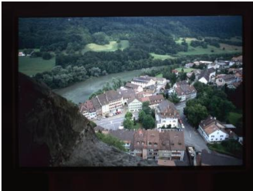
Aarburg. Veduta delle abitazioni sottostanti la torre del castello in direzione ovest
