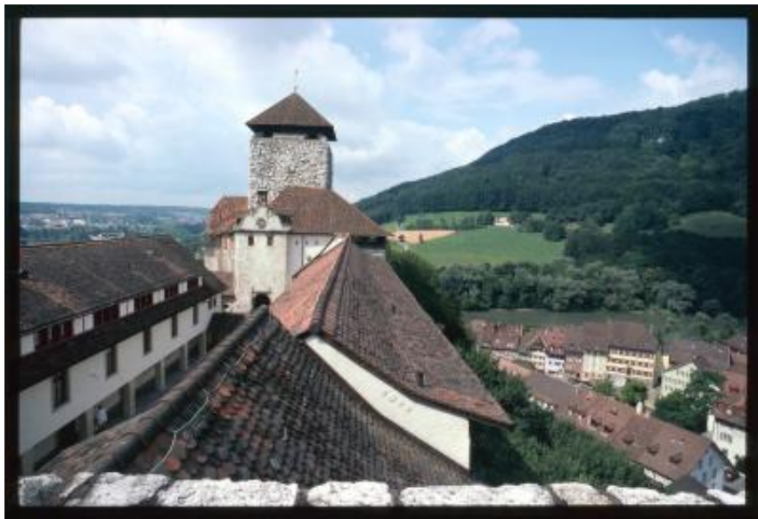
Aarburg. Veduta del castello dal camminamento settentrionale
