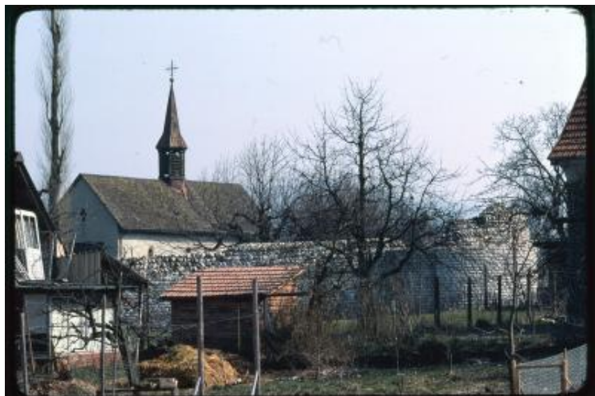
Bad Zurzach. Resti della cinta muraria del castello tardo romano di Tenedo
