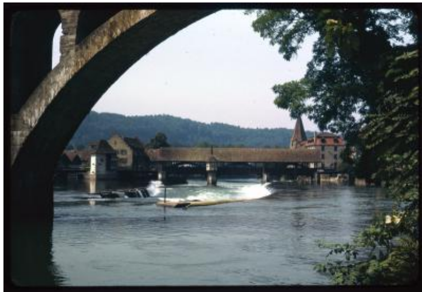
Bremgarten. Veduta dell'Holzbrücke incorniciato dall'arcata dell'Isenlaufbrücke
