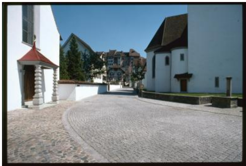
Bremgarten. Protiro della cappella di santa Clara e parte absidale della Chiesa parrocchiale di Bremgarten
