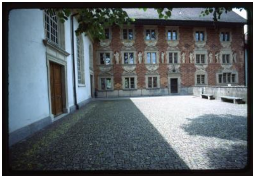
Brugg. Facciata dell'edificio limitrofo alla Chiesa riformata
