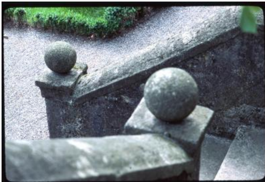
Möriken-Wildegg. Dettaglio del parapetto di una scala
