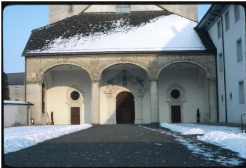
Muri. Dettaglio della facciata principale della chiesa dell'abbazia
