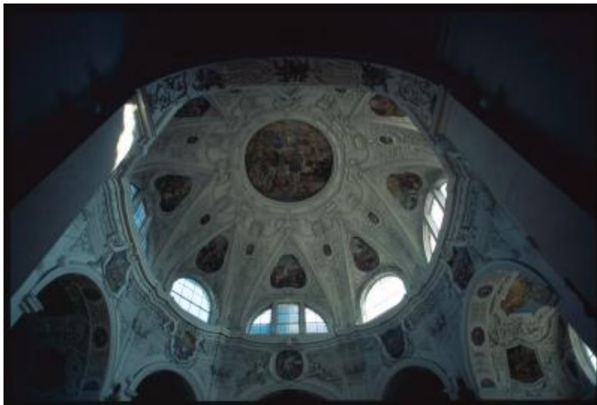
Muri. Cupola della chiesa dell'abbazia vista internamente
