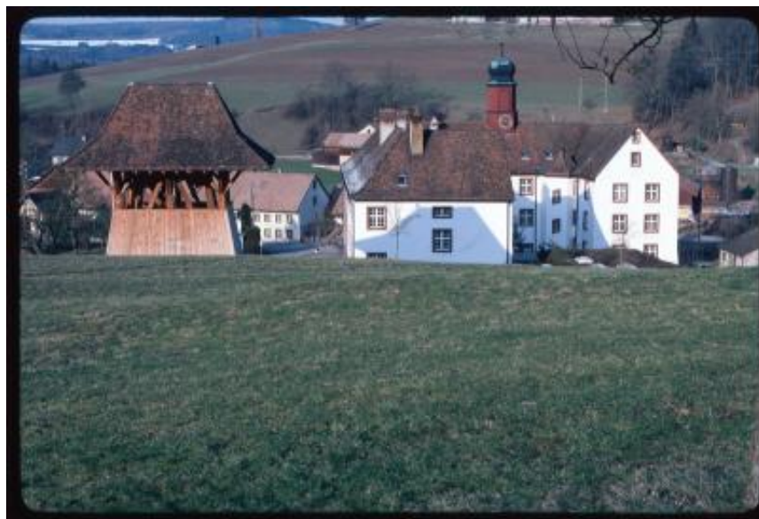
Wislikofen. Veduta del tetto del priorato benedettino
