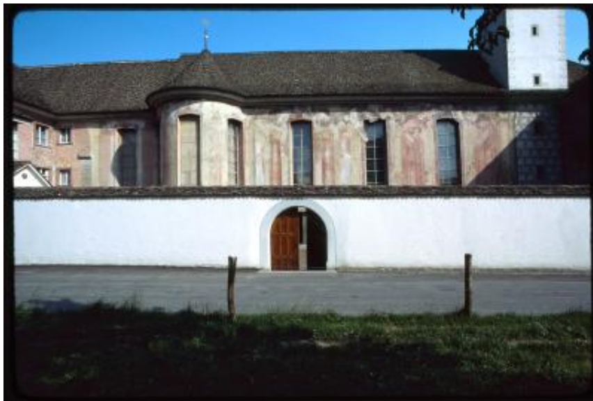
Würenlos. Portale di accesso al priorato di Fahr dal lato della chiesa
