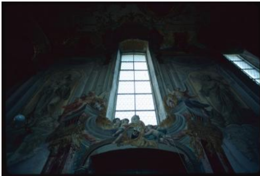
Würenlos. Dettaglio di una finestra vista dall'interno della chiesa del priorato di Fahr
