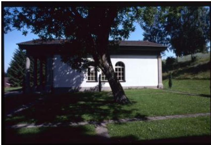
Zofingen. Facciata laterale di uno dei padiglioni di protezione dei mosaici romani
