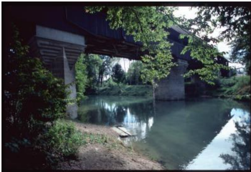
Aarberg. Dettaglio dei pilastri del ponte sull'Aare
