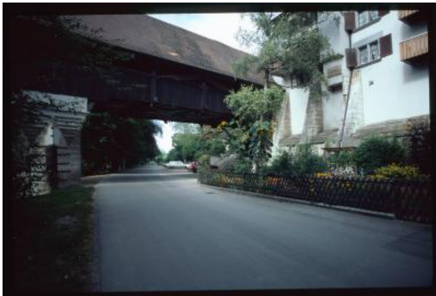
Aarberg. Dettaglio del ponte sull'Aare
