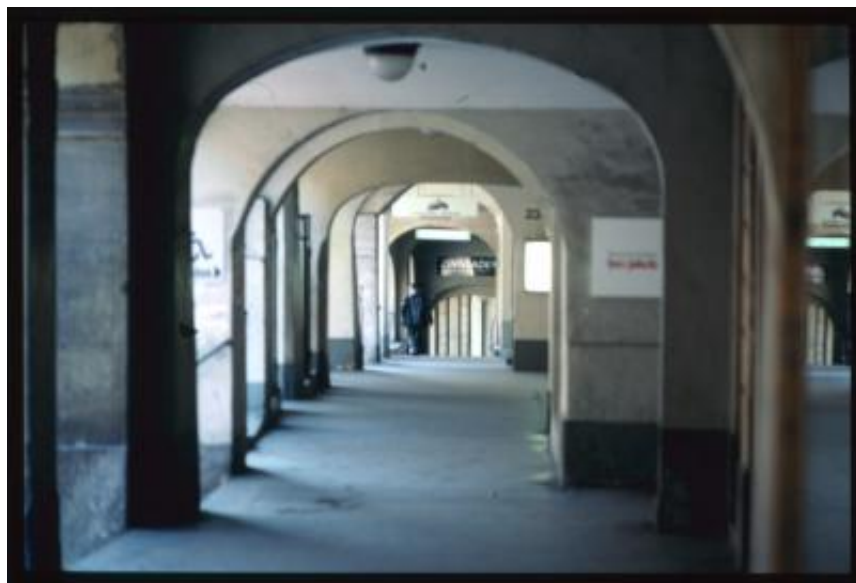
Berna. Dettaglio dei portici del centro storico
