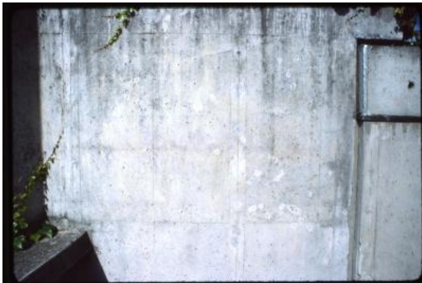
Kirchlindach. Dettaglio di un muro in cemento dell'insediamento di Halen
