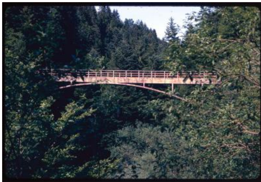
Rüeggisberg. Ponte di Schwandbach visto frontalmente
