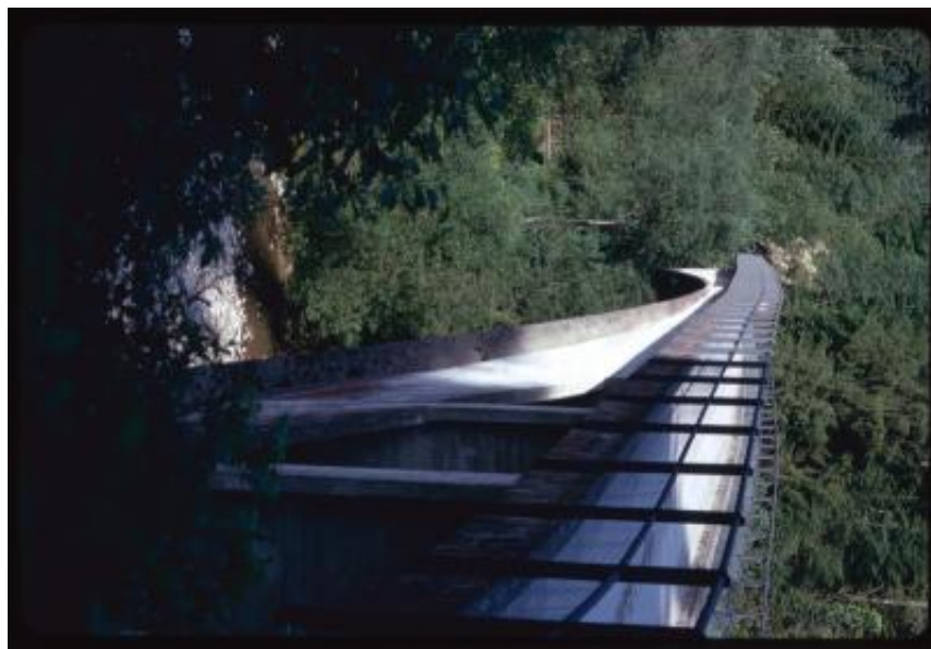
Schwarzenburg. Dettaglio del ponte di Rossgraben
