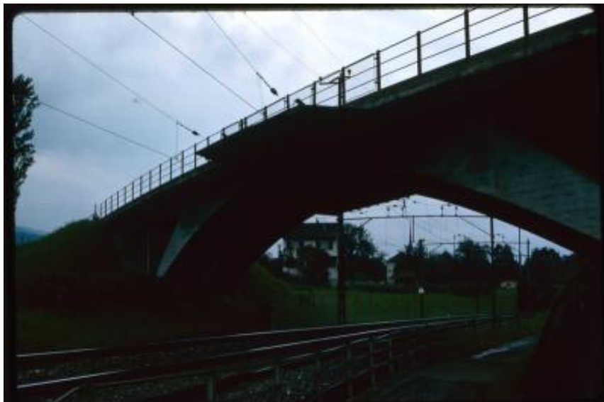
Altendorf. Dettaglio del Ponte sulla strada per Churerstrasse
