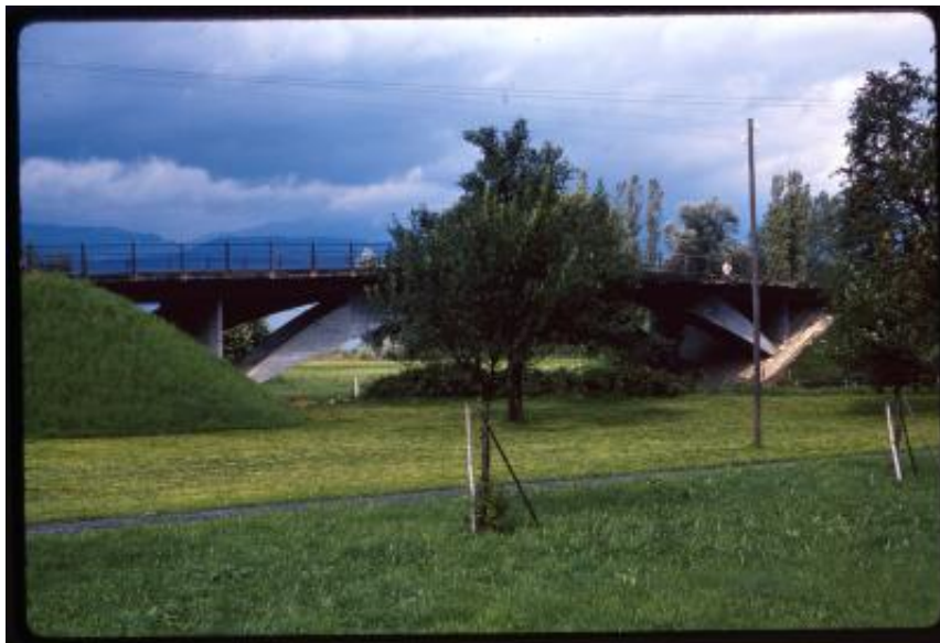
Altendorf. Veduta del Ponte sulla strada per Churerstrasse
