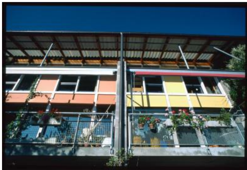
Worb. Dettaglio delle villette a schiera del complesso residenziale Bleiche
