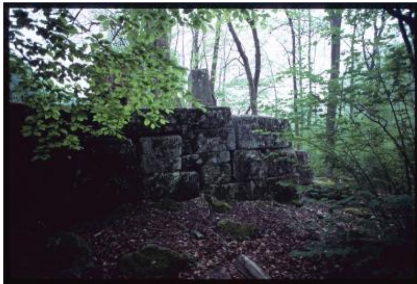
Isola di San Pietro. Dettaglio di un muro
