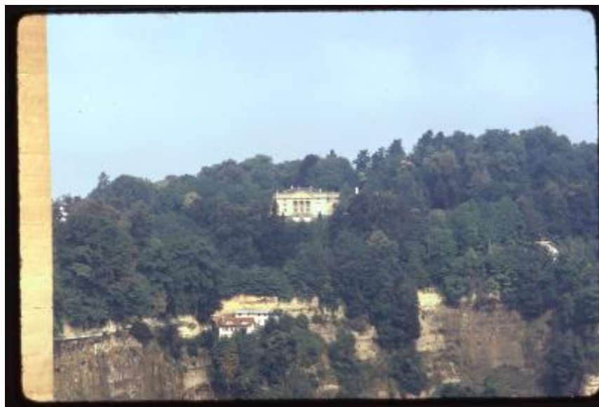
Friburgo. Veduta del castello della Poya
