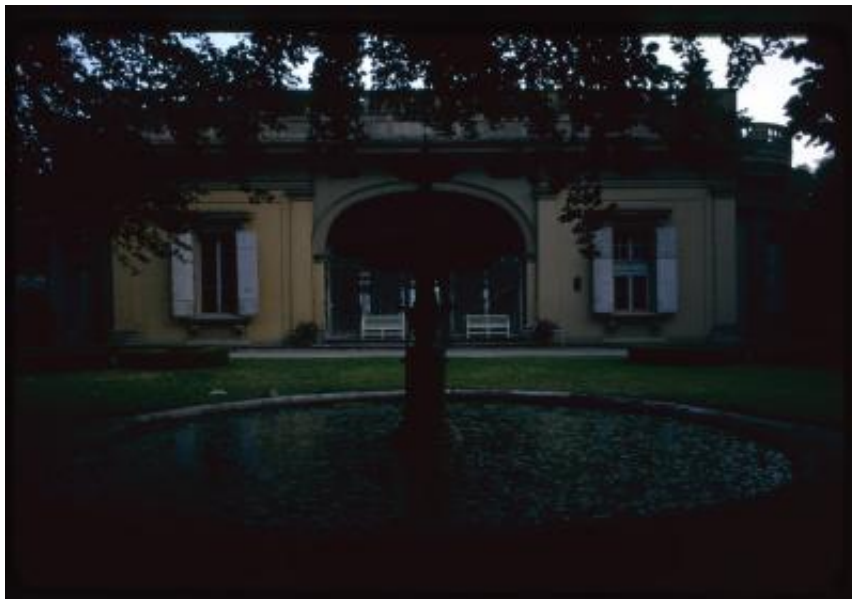
Friburgo. Facciata nord del castello della Poya vista frontalmente
