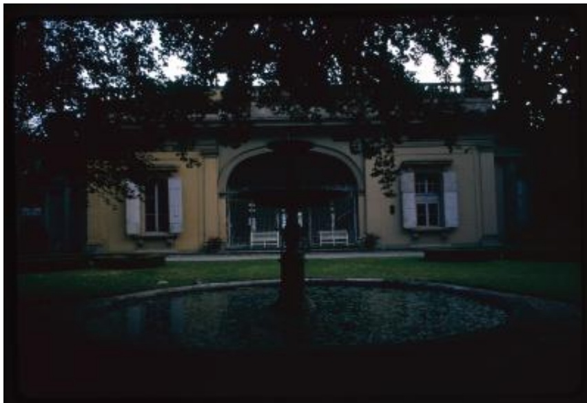
Friburgo. Facciata nord del castello della Poya vista frontalmente
