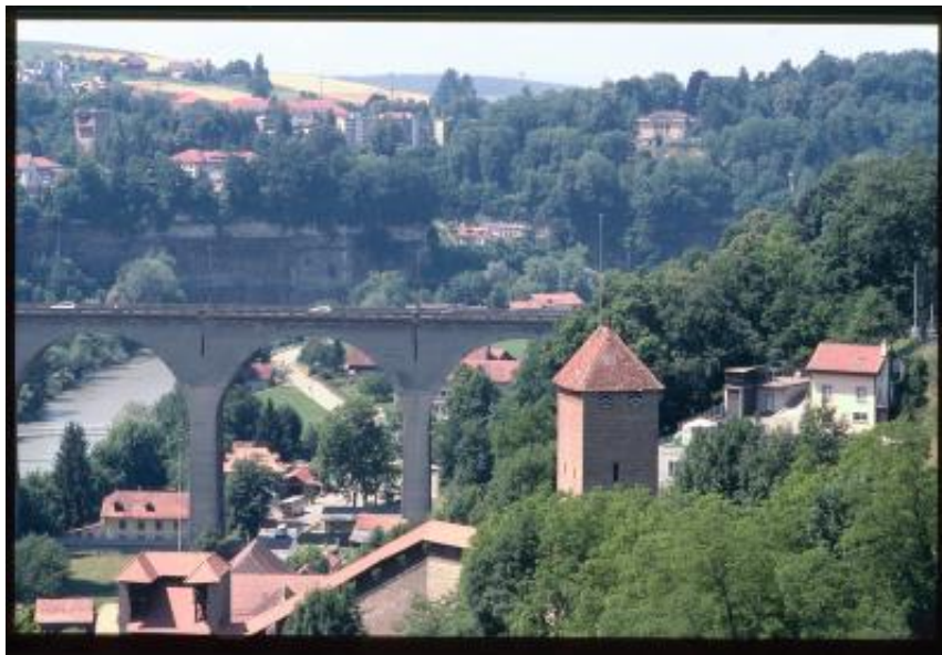
Friburgo. Dettaglio del ponte Zähringen
