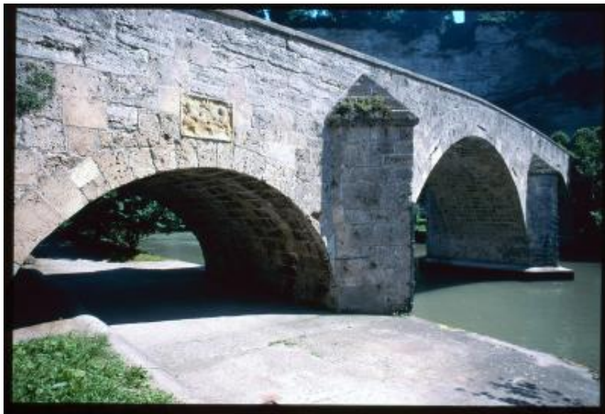
Friburgo. Fianco del Pont du Milieu
