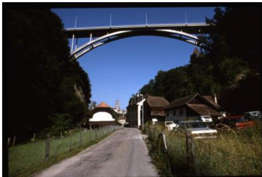
Friburgo. Pont du Gottéron dalla strada sottostante
